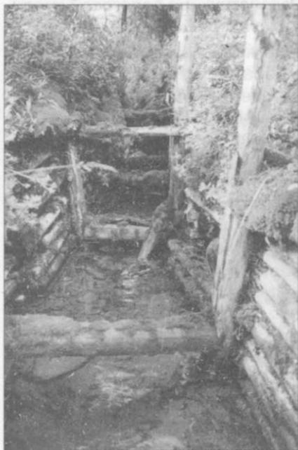
**Рамочная конструкция крепления траншеи, по которой была выведена минерализованная вода из старательского шурфа в долине реки Черной Бирюсы**
