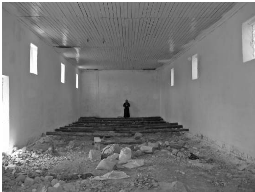
Помещение будущего музея до ремонта. Фото А. Тюриной
