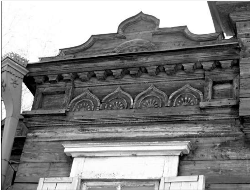
Ил. 7. Фрагмент главного фасада — венчающий фриз с пальметтами и килевидными арочками, фигурное венчание в уровне кровли
