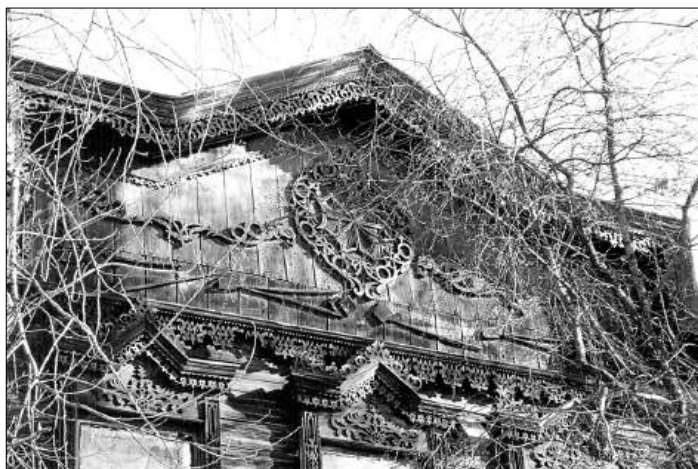
Фото 6. Дом на ул. Киевской, г. Иркутск
