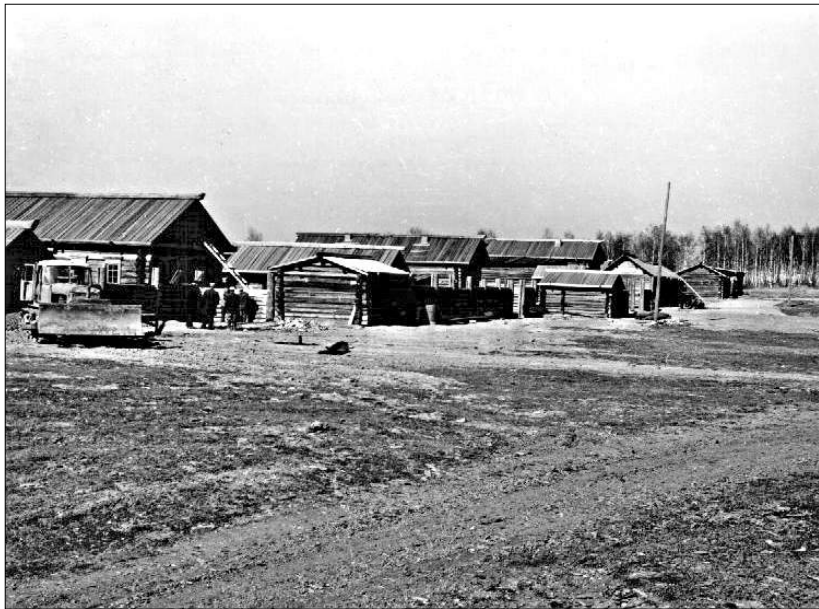
Подготовка территории деревни-малодворки к сдаче в эксплуатацию. 1980 г.
