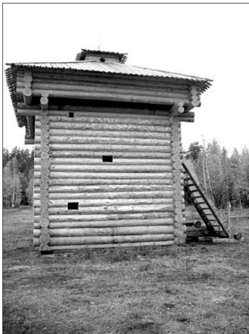
Реконструкция второй башни Братского острога. Фото В. Садовикова, 2013 г.
