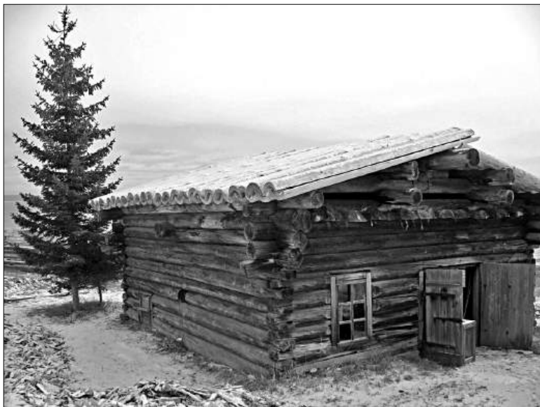
Кузница, реставрация кровли. Фото В. Садовикова, 2012 г.
