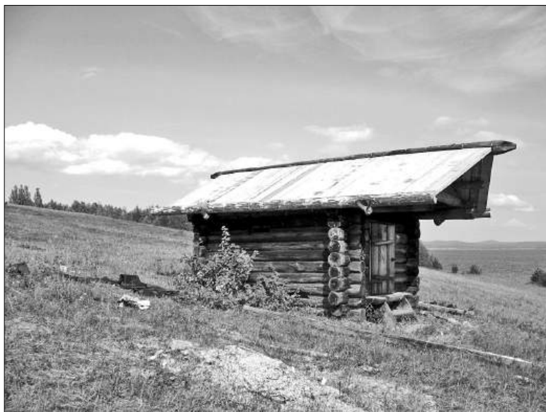
Баня, реставрация кровли. Фото В. Садовикова, 2012 г.
