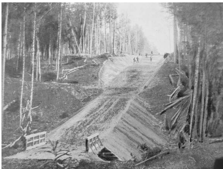
Строительство переселенческой дороги Фото из кн.: Азиатская Россия (СПб., 1914. Т. 1)
