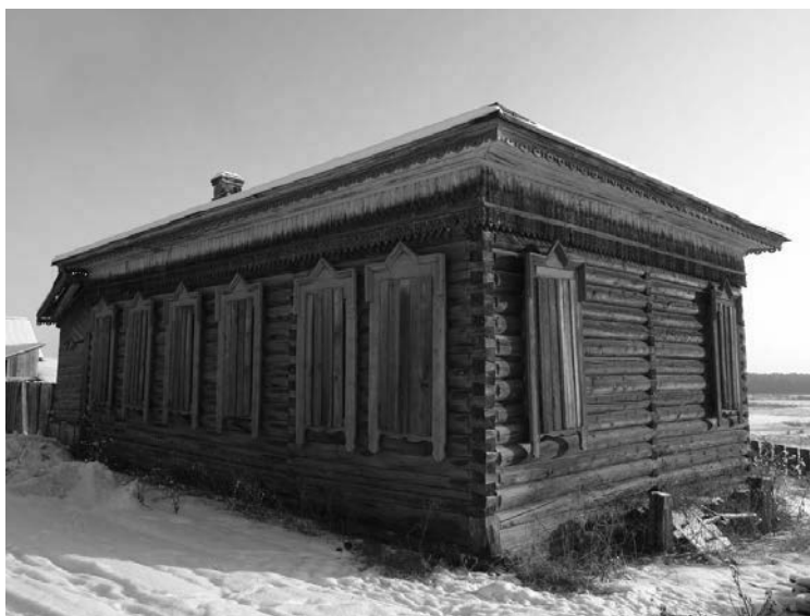
Дом священника в пос. Большой Кашелак Куйтунского района.
