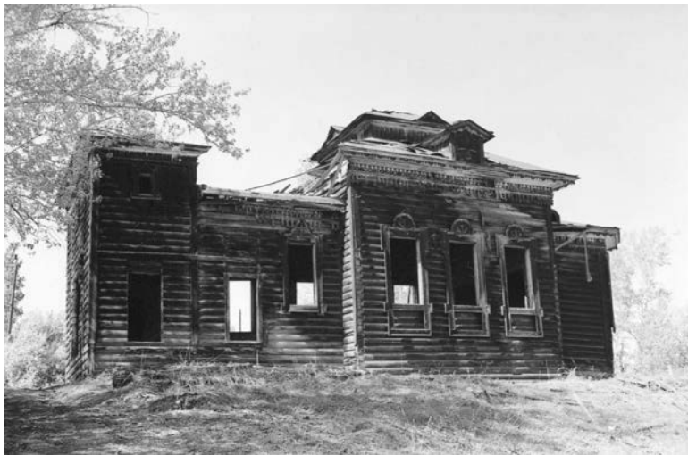
Церковь в пос. Большой Кашелак Куйтунского района. Фото В. В. Тихонова, 2011 год
