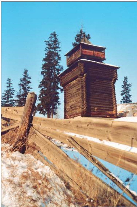
Башня Бельского острога. Фото В.В. Тихонова
