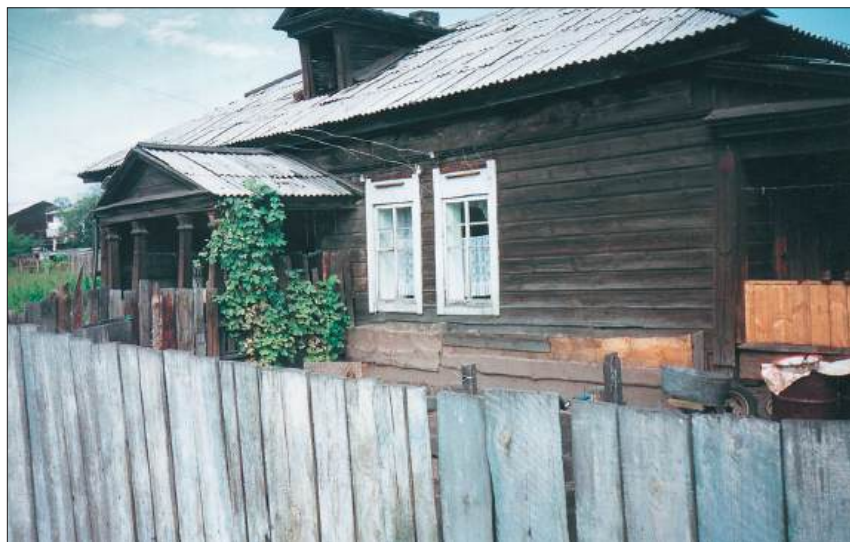
Дом начальника этапной тюрьмы, сейчас — жилой дом, село Залари. Фото А.К. Нефедьевой
