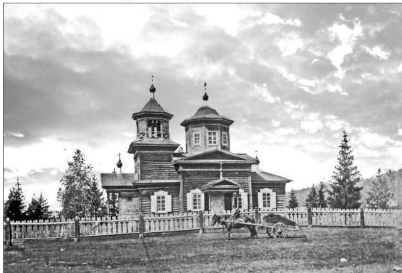
54. Приписной Прокопиевский храм в Усть-Кутском солеваренном заводе
