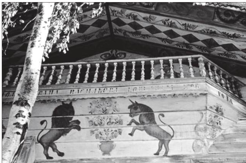
Деревня Петергино Вельского района. Дом И.В. Горбунова (не сохранился). 1886 г. Роспись подшив- ки балкона: лев и единорог. Фото М.И. Мильчика. 1969 г.
